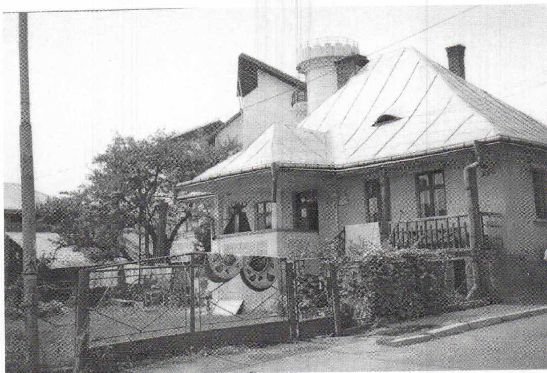
Fig. 13. Casă de pe str. Armenească, nr. 47 – starea actuală.
