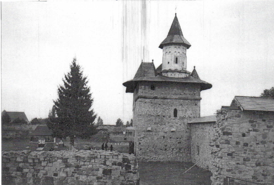
Pl. VIII. Fațada exterioară, vestică a paraclisului (SV-II-m-A-05485.03) – starea actuală
