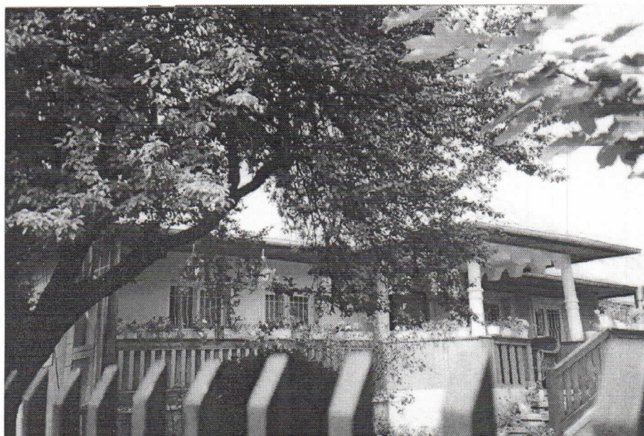
Fig. 10. Casa Roșu – starea actuală.
