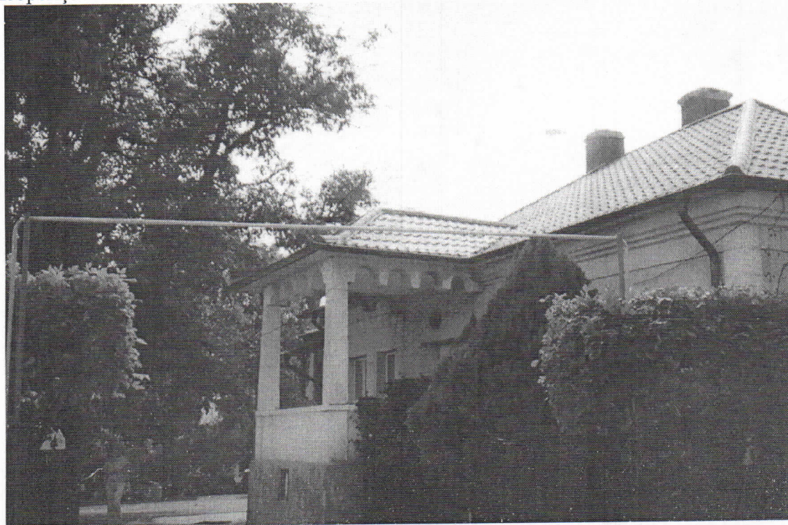
Fig. 6. Casă str. Armenească, nr. 7 – starea actuală.
